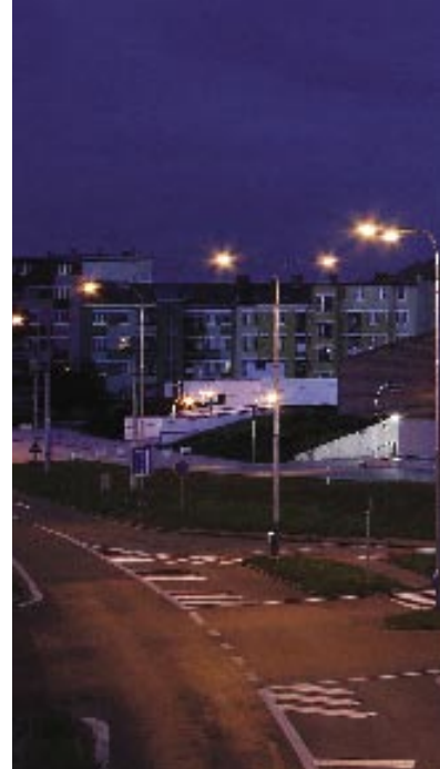
12 Přístavba ČEZ Arény v Ostravě, 2007, vizualizace, od návrhu po autorský dozor 13 Pohled na sportbar - přístavba ČEZ Arény v Ostravě, 2007, od návrhu po autorský dozor 14 Přístavba ČEZ Arény v Ostravě, 2007, od návrhu po autorský dozor
