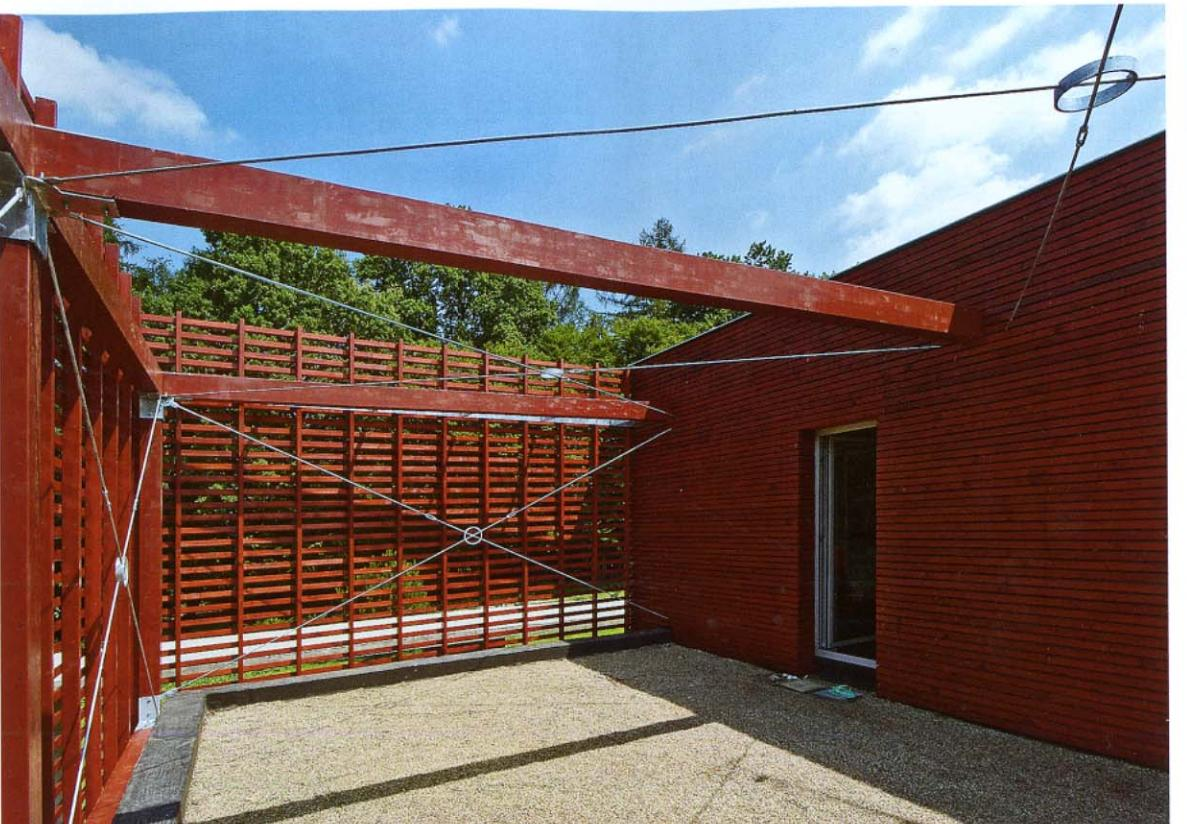
Nad automobilovým stáním se nachází terasa, po obvodě lemovaná latovým roštěm nahrazujícím zábradlí. Kvůli větru je konstrukce stažena ocelovými pruty
