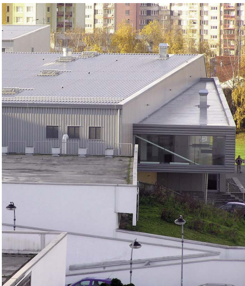
Pohled na střechu a severní vychýlenou část štítové stěny.
