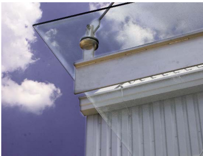
Detail upevnění markýzy nad pokladnami.
